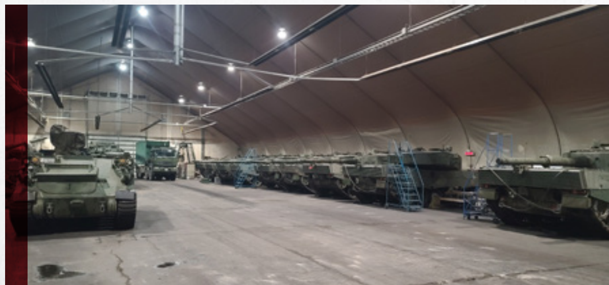
Destinée à servir de lieu temporaire pour l'entreposage des Leopard 1C2, cette structure de tente vieille de plusieurs décennies sert d'installation principale pour l'entreposage des chars de combat du LdSH(RC). Le Directeur - Infrastructure de la Force terrestre considère que la structure temporaire est périmée et n'a pas exprimé l'intention d'investir dans son entretien. Crédits photographiques : Sgt Larriveé-Larouche
